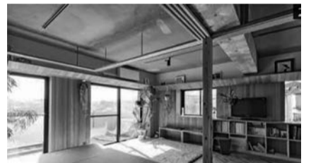
豊かな外部環境を常に感じられるよう設計した。「木の羽」と名付けた窓周りの造作により、既存の五つの窓を一体化させることで、空間の伸びやかさと生活の機能空間を統合するデザインを施した。さらに、自然光を室内に拡散したり、引き伸ばす役割も担うこと
