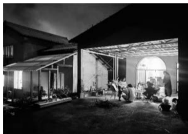
写真上 改修前。2軒が並ぶ2棟の空家 写真下 改修後。屋根のついた「ソト広場」、家の雰囲気が薄く、来客の方も自由に過ごせる空間に
